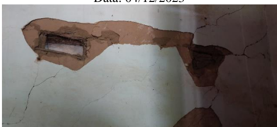
Alvenaria deteriorada
